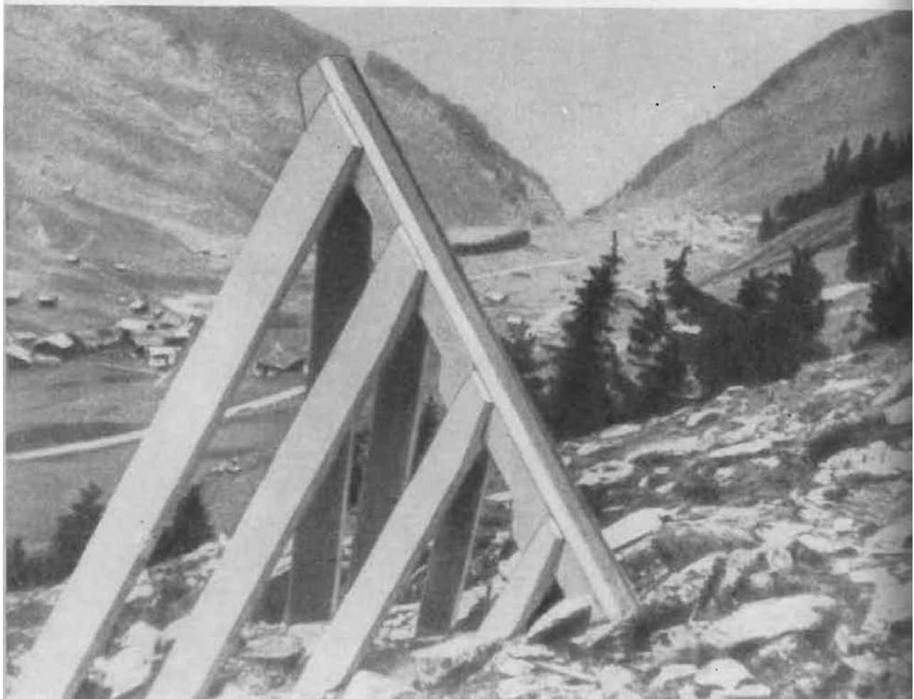
Фото 70 и 71. Современные методы застройки склонов, предупреждающие отрыв лавин; наклонные мосты из сборных железобетонных конструкций и лавинорезы.
